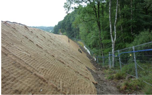
Beispiel für eine Begrünung mit Saatgutmatte
