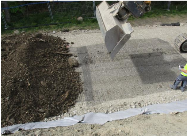
Verlegung der Geogitter und Bodeneinbau
