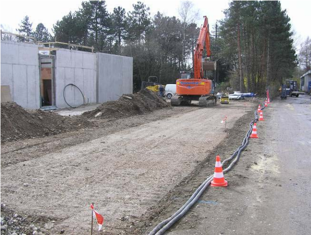
Herstellung der Dammaufstandsfläche..
