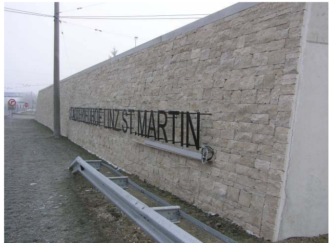
LSW im Eingangsbereich, mit Steinverkleidung.
