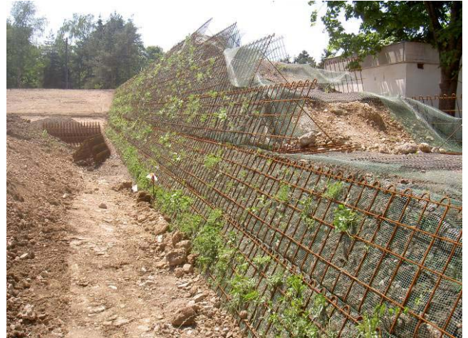
Herstellung des Längswalles, erster Bewuchs stellt sich bereits in der Bauphase ein.
