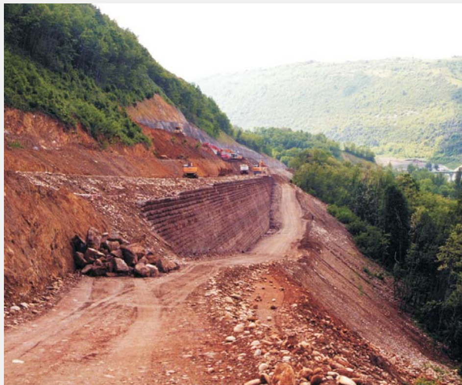
Teilweise begrünzte Steilböschung während des Bauzustandes
