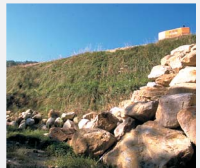
Teilweise begrünzte Steilböschung während des Bauzustandes
