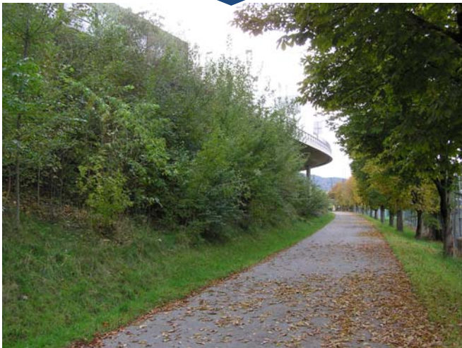
A12, Abfahrt Innsbruck Ost: ca. 4 Jahre nach Fertigstellung.
