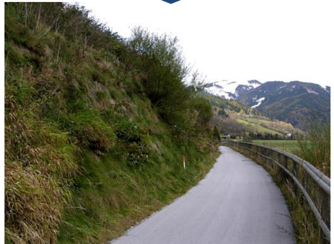
A9, Rastplatz Kalwang: ca. 4 Jahre nach der Fertigstellung hat sich ein robuster, flächen-deckender Bewuchs eingestellt!
