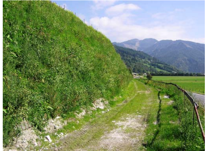
Begrünung über Hydrosaat „A9, Rastplatz Kalwang“, 5 Monate nach der Fertigstellung.
