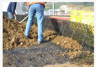
Sorgfältige Verlegung des Erosionsschutzgitters und erstes Schütten
