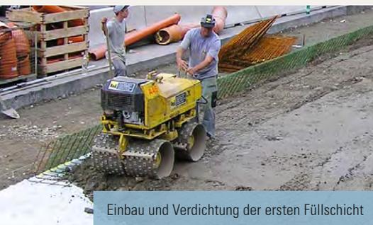
Einbau und Verdichtung der ersten Füllschicht
