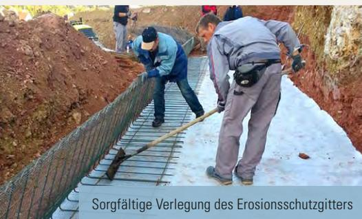
Sorgfältige Verlegung des Erosionsschutzgitters
