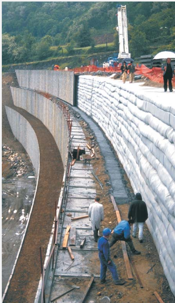
Die außergewöhnlichen mechanischen und hydraulischen Eigenschaften von TenCate Polyfelt Rock PEC erlauben auch den Bau extrem hoher Stützkonstruktionen.
