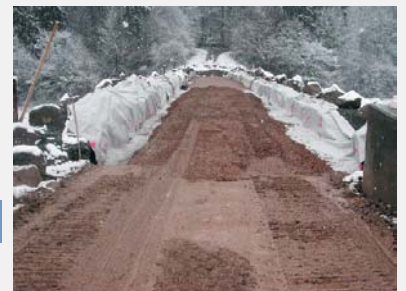
Damm in der Bauphase
