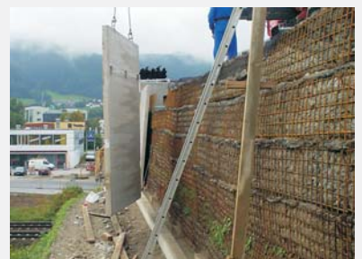
Versetzen der vorgefertigten Stahlbeton-Paneele in den Bereichen mit 10:1 Neigung.
