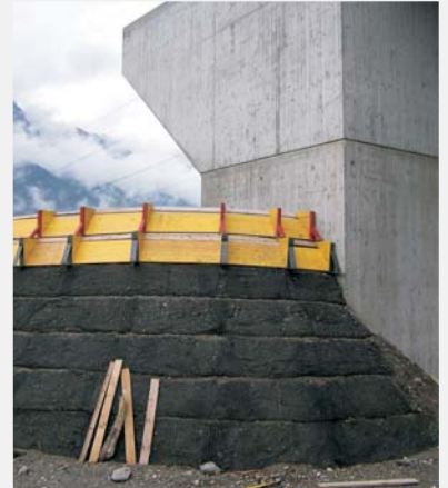
Schalung dient als Schalung für die Errichtung der geotextilverstärkten Stützkonstruktion (60° Neigung).
