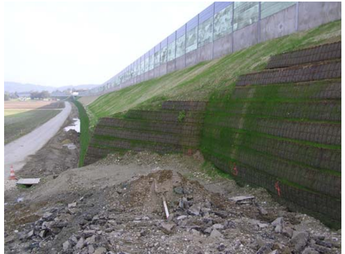
Das System der bewehrten Erde erlaubt nahezu beliebige Geometrie. Böschungsrücksprünge, Ausnehmungen, etc. sind problemlos ausführbar.
