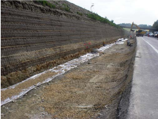
Ausführung einer Einschnittsböschungen entlang der Autobahn.
