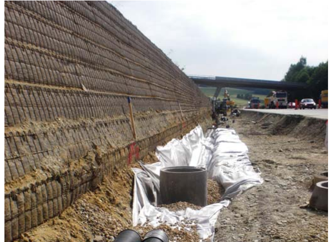
Ausführung der Straßenlängsdrainage im Bereich des Böschungsfußes.
