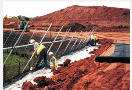
Gebogene Stahlgitter dienen als verlorene Schalung zur Errichtung der bewehrten Stützkonstruktion.
