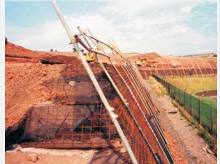
Detailansicht der Schalung
