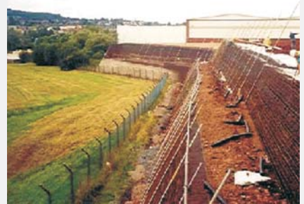
Auf halber Höhe der Böschung wurde eine Berme für Bepflanzung und Pflege vorgesehen.
